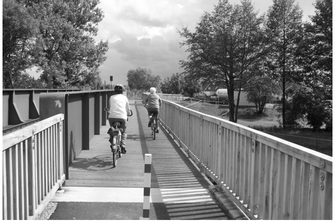
neue Fuß- und Radwegbrücke
